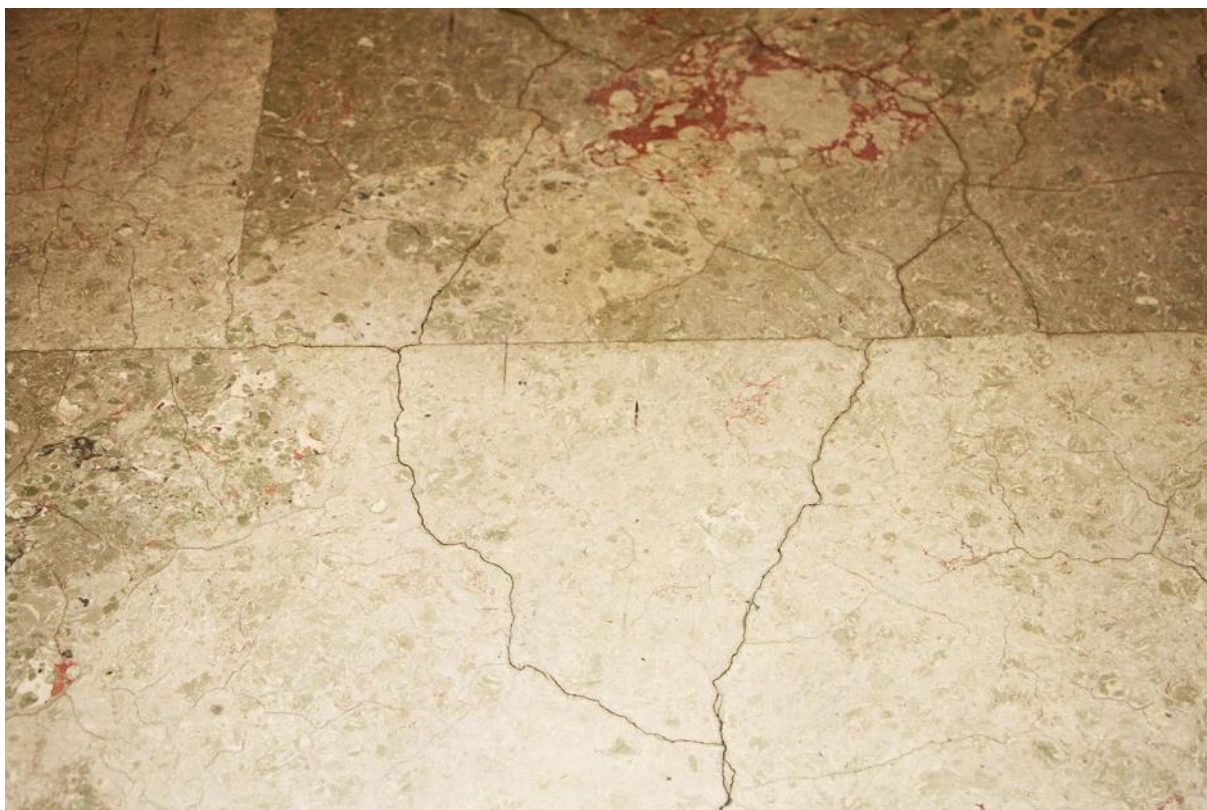
Hosszan lehúzódo vertikális repedések az oldalfalak alsó, 4 méteres szakaszán.
