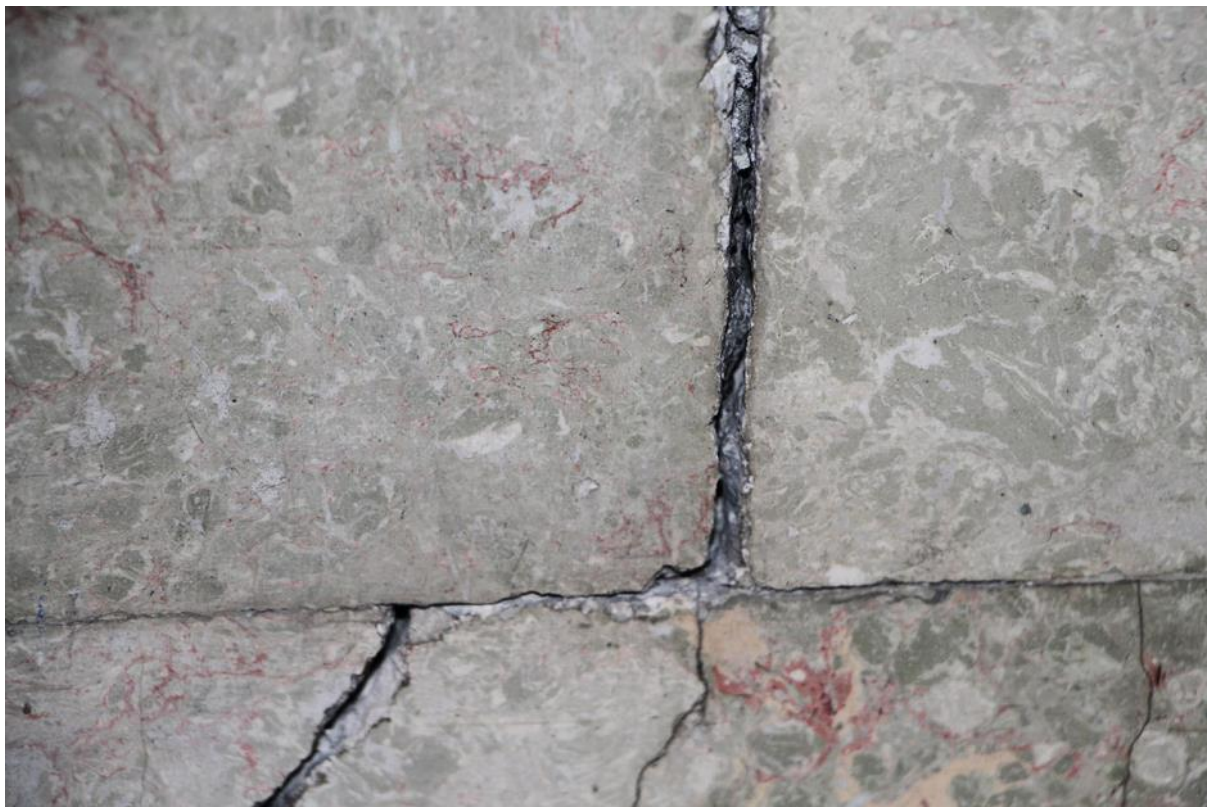
Jellemző repedések az oldalfalak párkány alatti, kváder mintás felületein. Ezek a repedések oka az épület mozgása.
