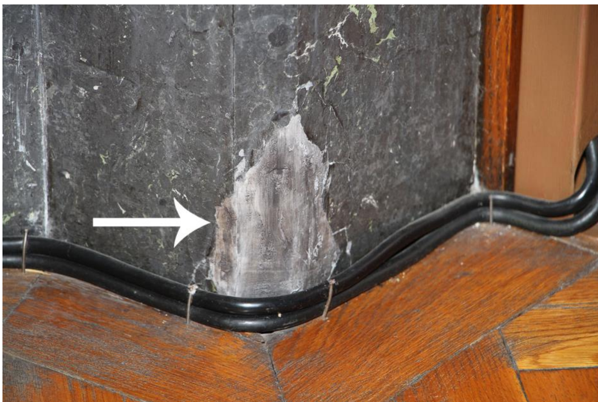
Az ajtókeretezések jellemző sérülései. Fent a felső éleken kisebb kitörések, alul ideiglenes javítás. Alul az ideiglenes javítás felületéről lekopott a festés.
