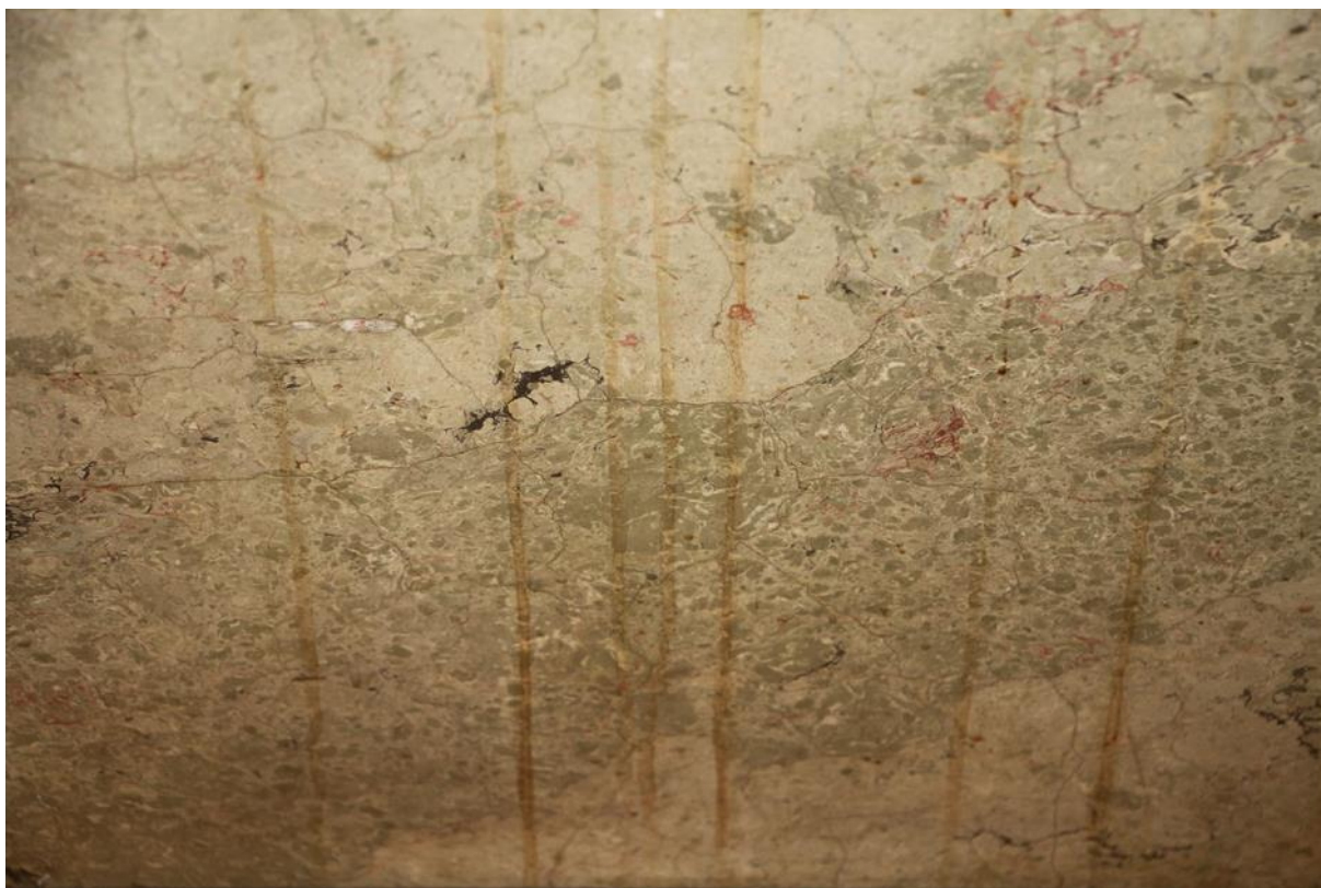
Az ablakok felőli oldalfal legalsó szakaszainak jellemző szennyeződése a fotókon látható sűrű, enyhén vöröses színű csorgásnyom.
