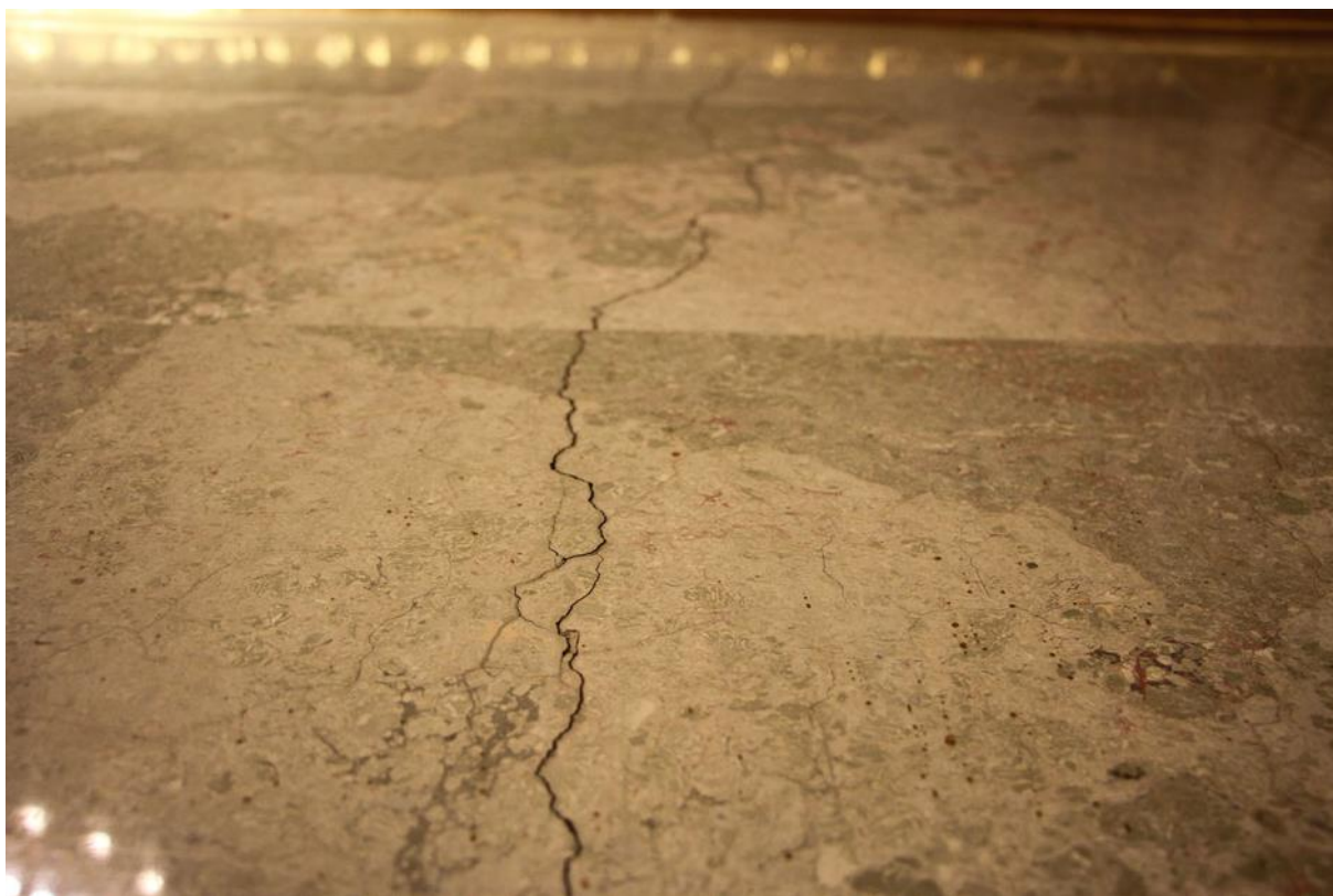
Hosszan lehúzódo vertikális repedések az oldalfalak alsó, 4 méteres szakaszán.
