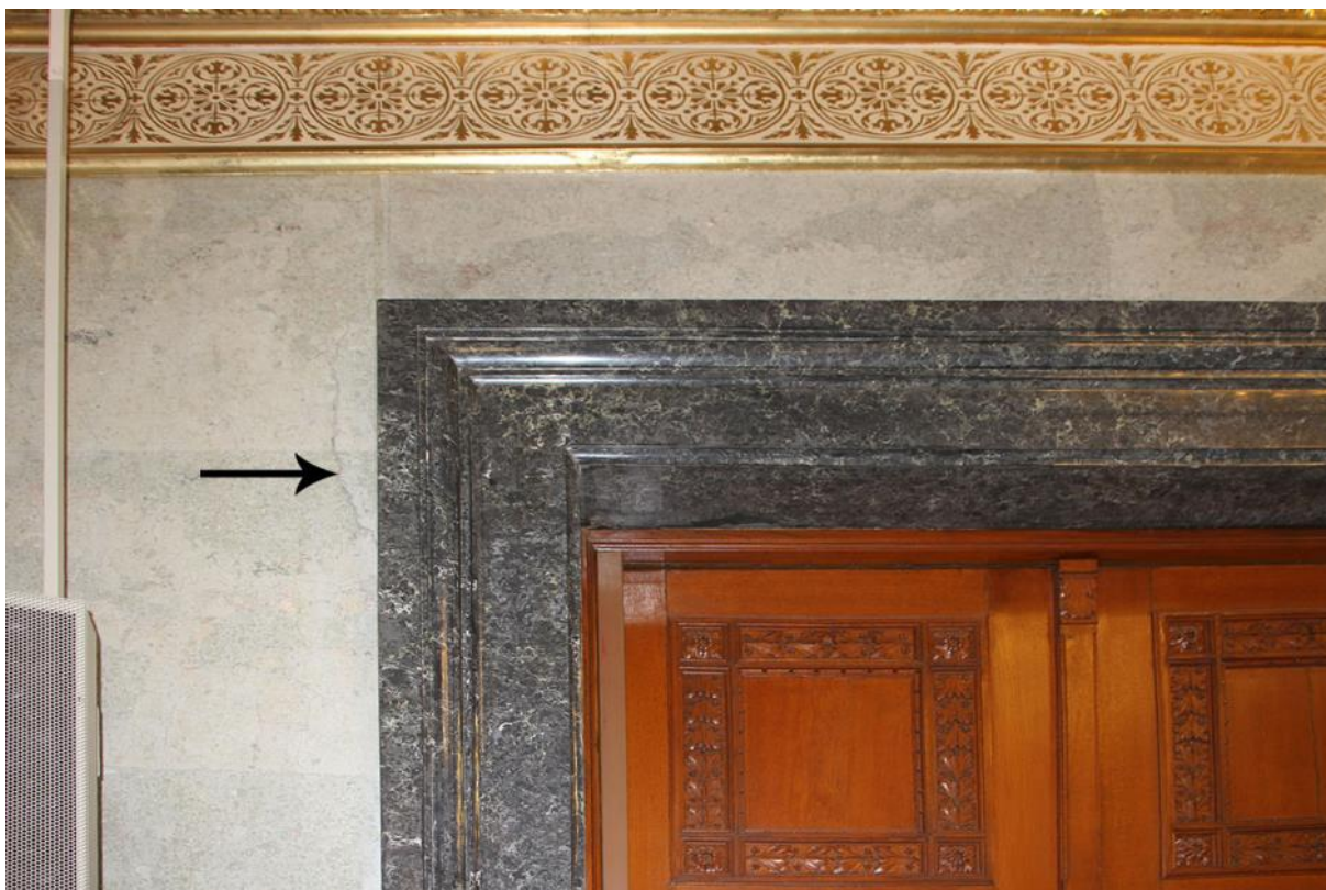
Jellemző repedések az ajtók felső sarkai körül.
