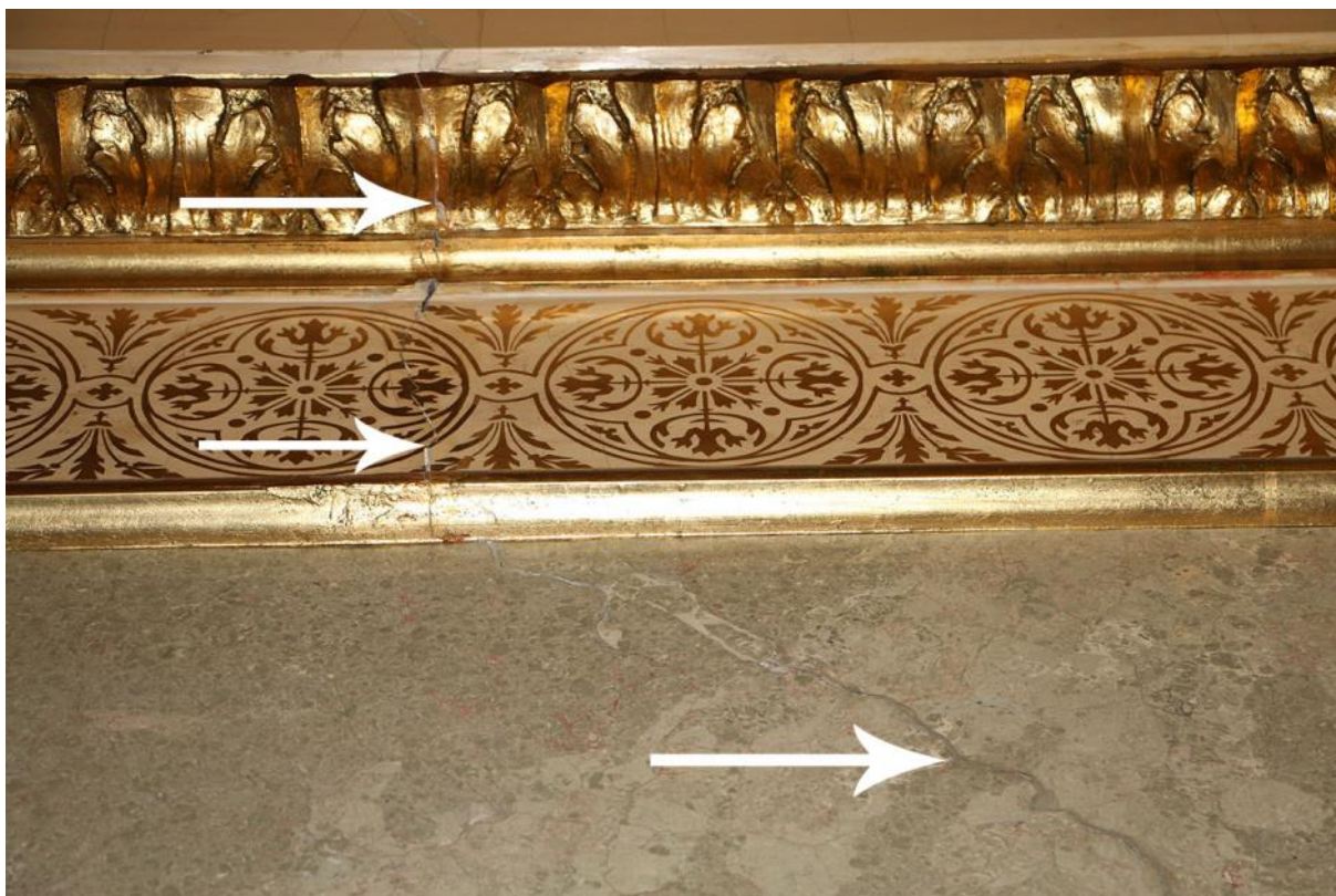
Az ajtóktól induló repedések sokszor keresztülfutnak a párkányokon is.
