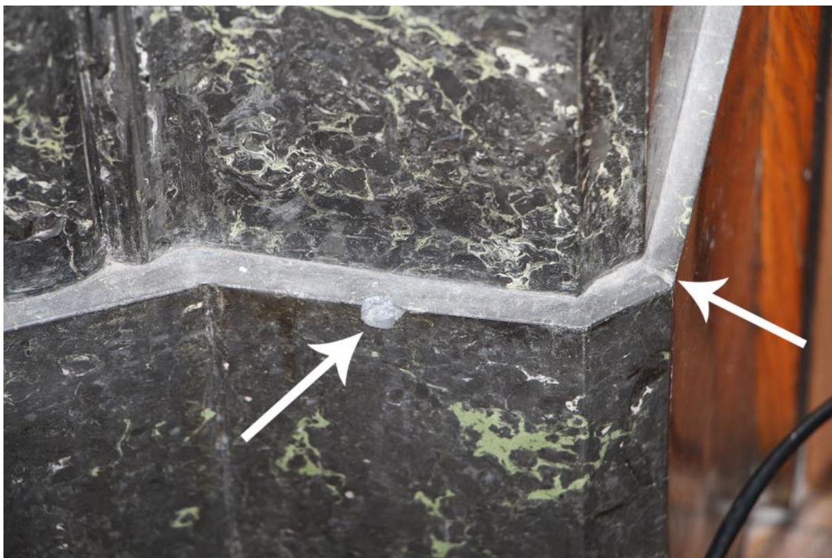
Fent csorbulás az ajtókeret lábázatának felső élén. Alul utólagos pótlás az alsó élén.
