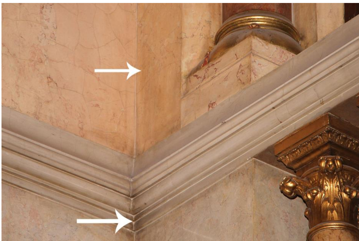
Erősebb szennyeződés lerakódások a sarkok környékén. Meg kell kísérelni eltávolításukat a felületek felsértése nélkül.
