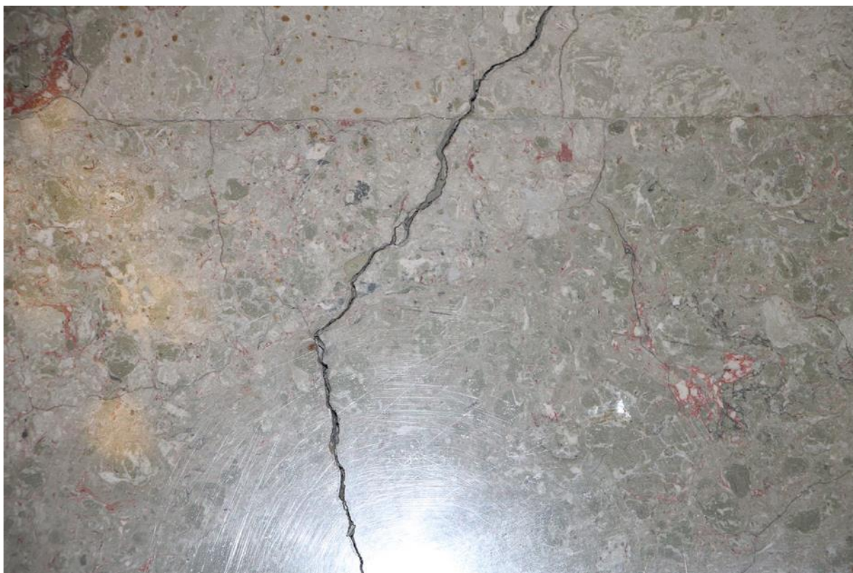
Jellemző repedések az oldalfalak párkány alatti, kváder mintás felületein. Ezek a repedések oka az épület mozgása.
