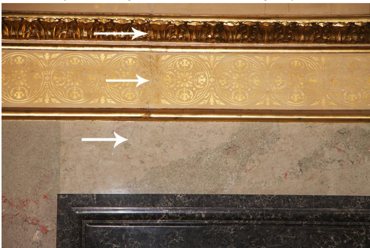
Az ajtóktól induló repedések sokszor keresztülfutnak a párkányokon is.
