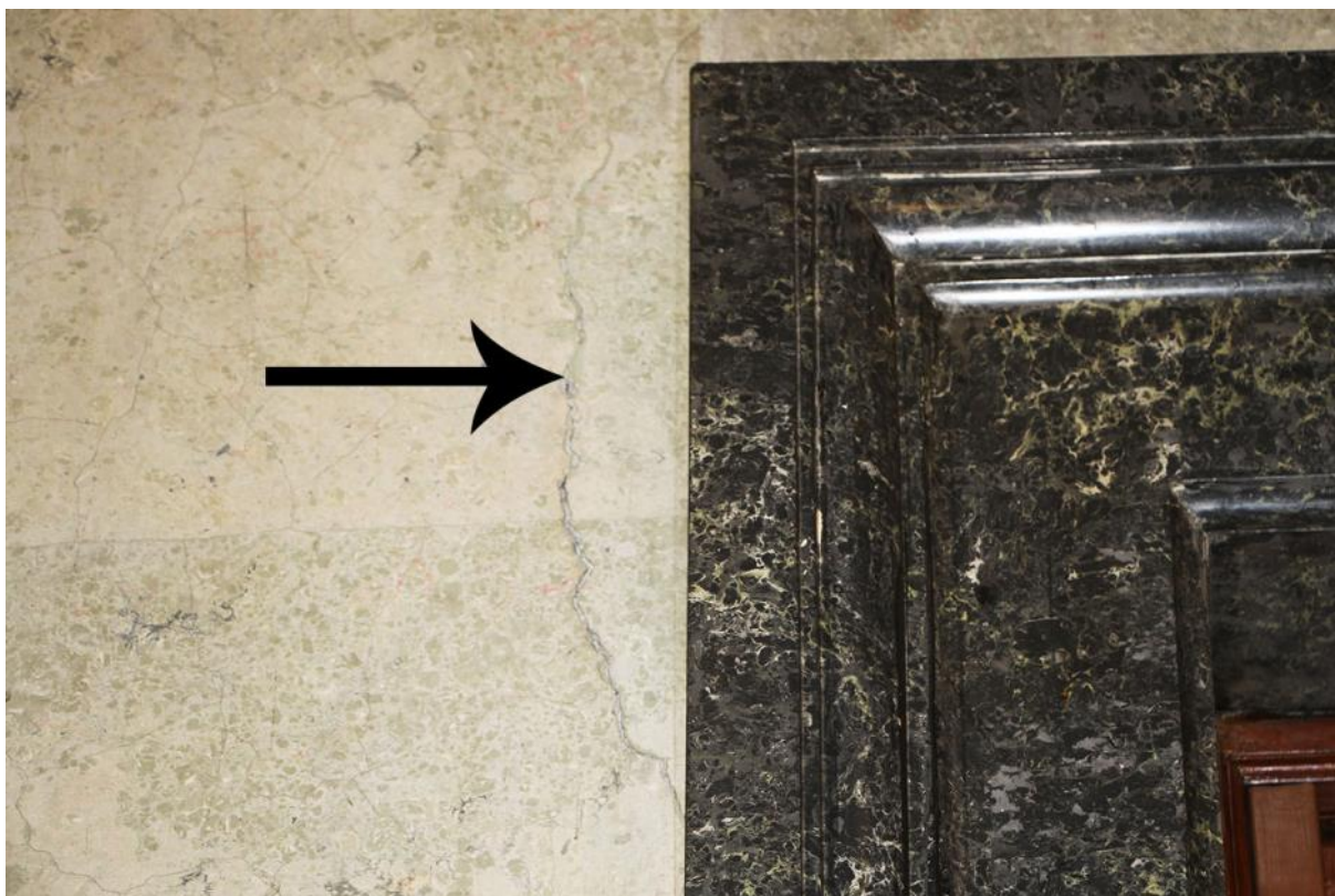
Jellemző repedések az ajtók felső sarkai körül.
